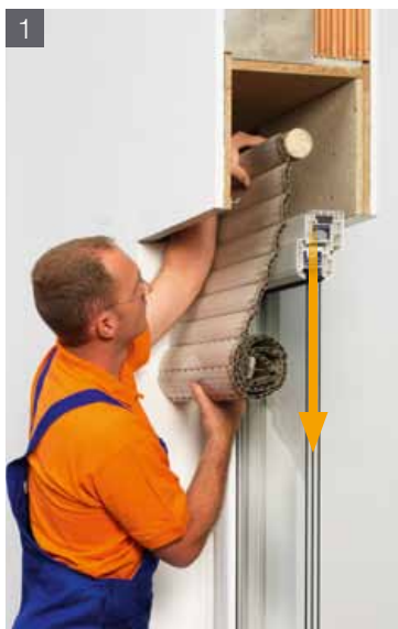
1 Alten Rollladen aus Kasten entfernen!
