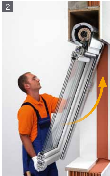
2 Fenster mit TERMO einsetzen!
