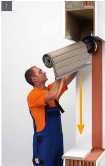
1 Alten Rollläden aus Kasten entfernen!
